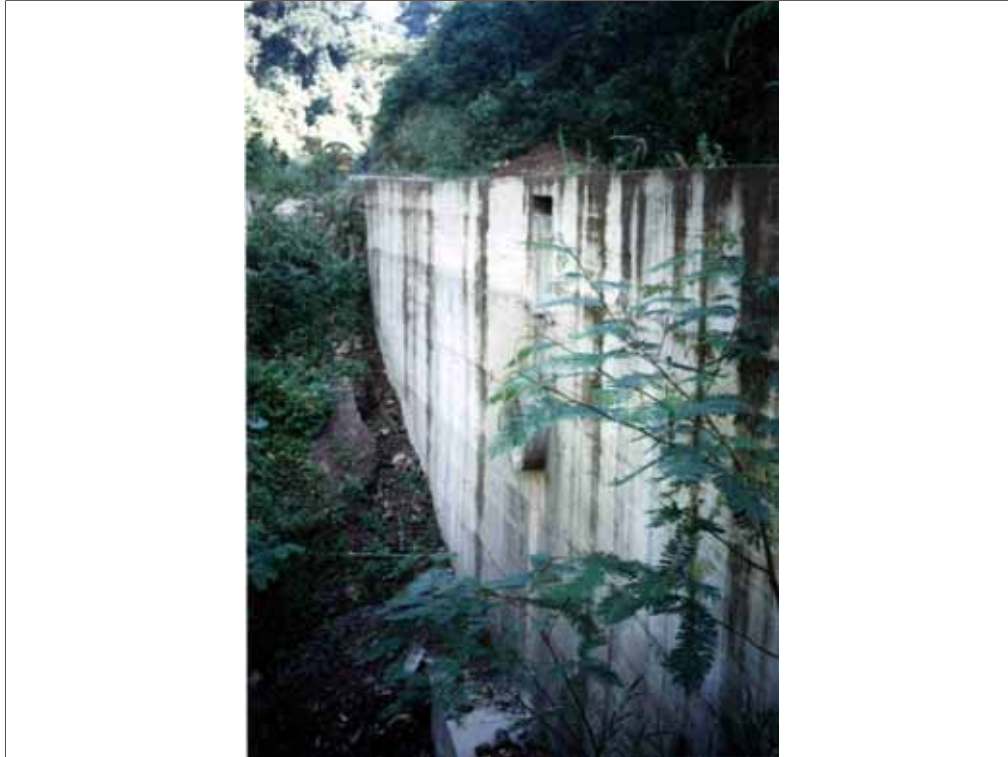
Foto 5. Estación G21. Muro alto cimentado sobre coluviones estables. Detrás afloran lodolitas de la Formación Trincheras. Fue terminado en julio 29 de 1998 y no muestra inestabilidad.
