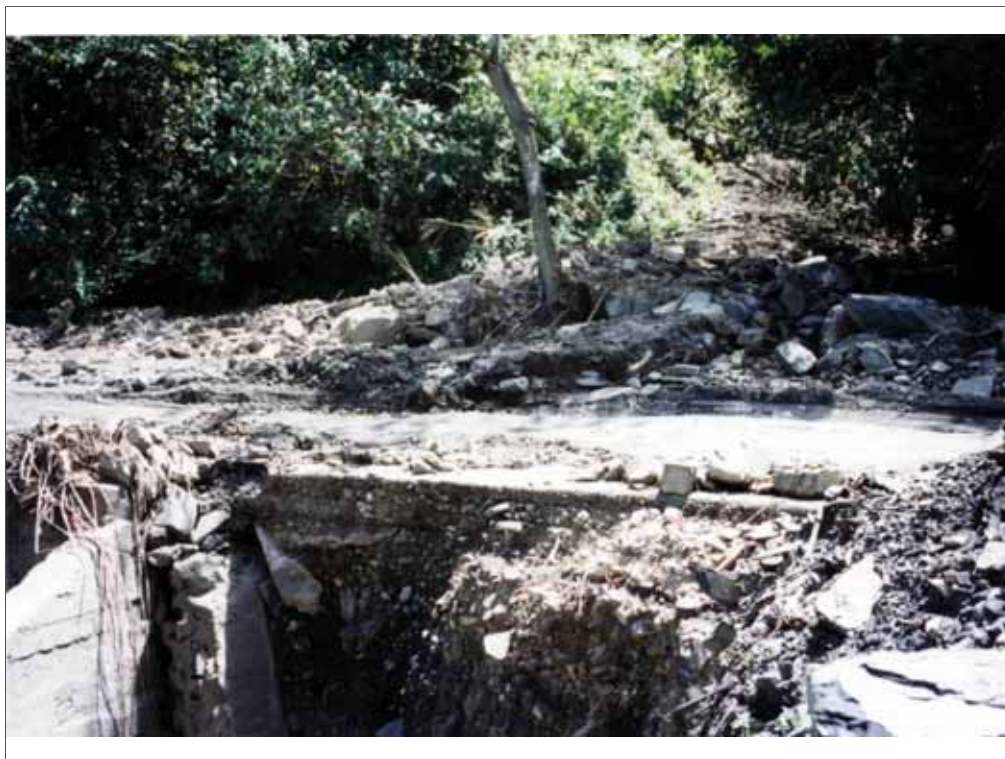
Foto 15. Flujo de detritos que colmató el box-culvert de la carretera en la abcisa K 5 + 950, durante la primera semana de junio de 1999.
