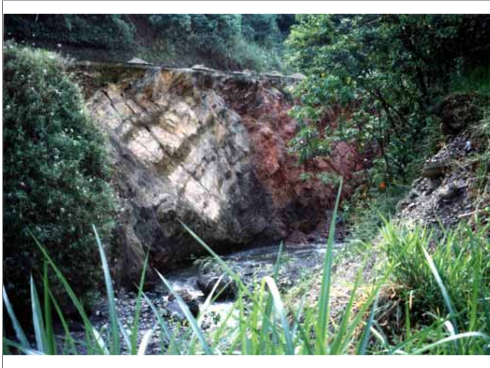
Foto 7. Estación G8A. Mismo sitio de la Foto 6. En la estación G8, en la base del talud, afloran lodolitas negras con grandes concreciones piríticas, moderadamente meteorizadas, débiles.
